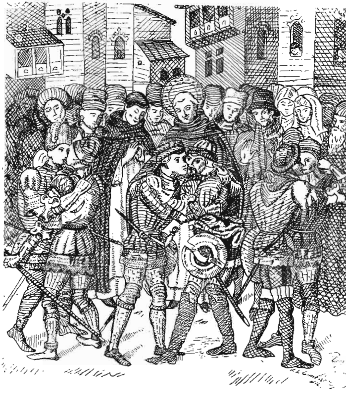
Reconciliació dels Centelles i els Solers. Gravat aparegut a Glorias Vicentinas , Butlletí de l'Associació de la Pila Baptismal de Sant Vicent Ferrer (València, 1969). Cedida per En José Castell.
