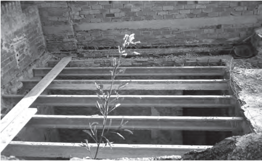
Demolició del sostre de biguetes de formigó.
