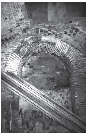
Un dels dos arcs apuntats, a l'interior de la sala de la planta baixa.
