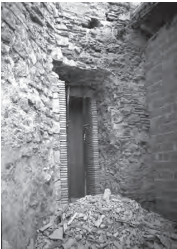
Transformació d'una finestra d'obertura recent en el nou accés al conjunt.
