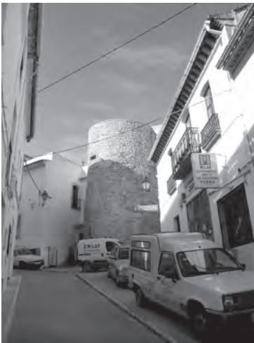
La torre de la Comare després de la intervenció.
