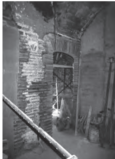
Recuperació de les brancalades i l'arc de comunicació entre la torre i la sala.
