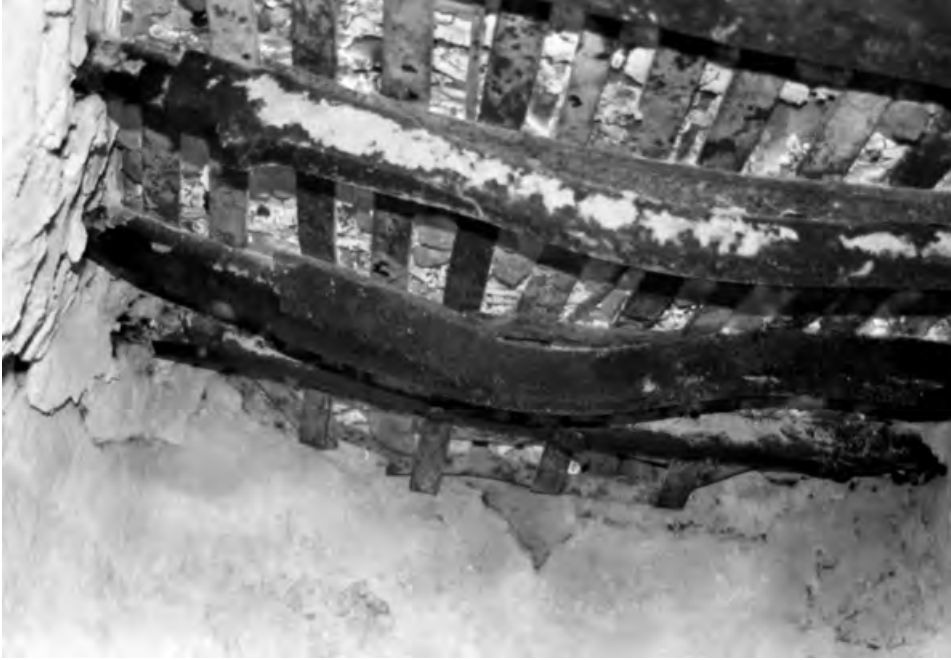
Graella base formada per eixos de roda (grossos) i ferrets (estrets) (Autor de la foto: Josep Bolo Gràcia, ca. 1991).
