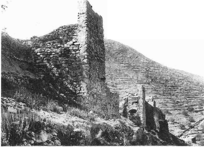
Llenç septentrional de la fortalesa de Nules. Cal remarcar-hi la presència del tapial i de les torres de base quadrada (F. Arx. Mas)
