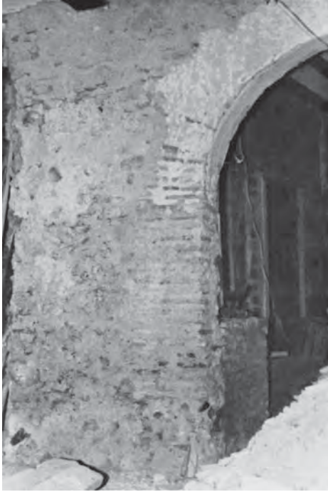
Vestigis de la construcció primitiva en l'arc del vestíbul
