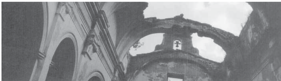
Vista interior de la inexistent coberta
