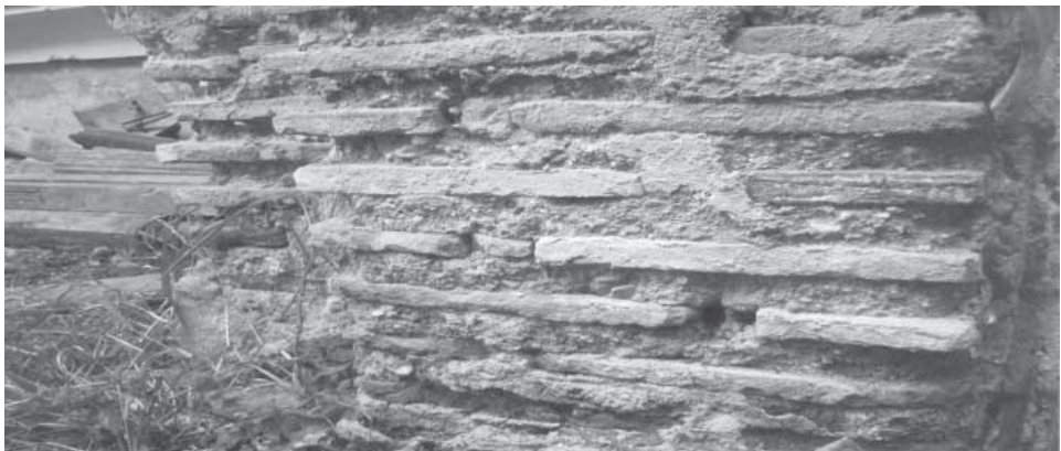
Vistes de les rajoles a la base dels pilars.
