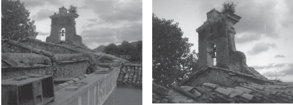
Vistes de la coberta.
