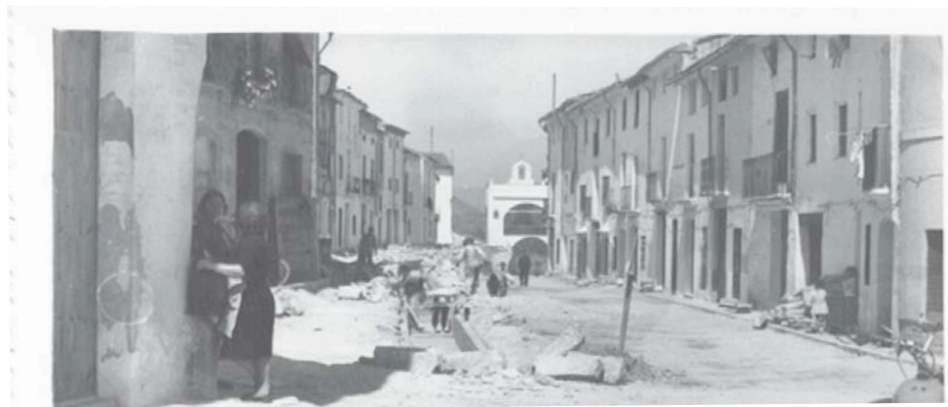
Canalització coberta de la séquia Mare al seu pas pel carrer Sant Vicent
