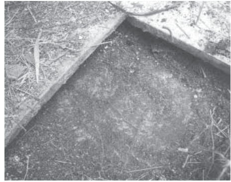
Vistes del paviment.
