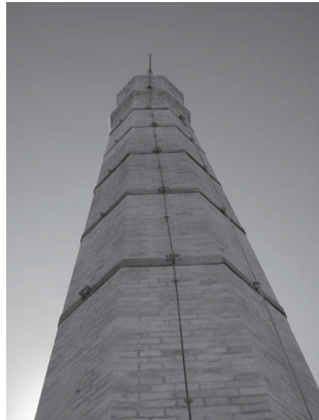
Vista de després de les obres
