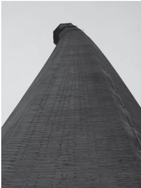
Vista d'abans de les obres
