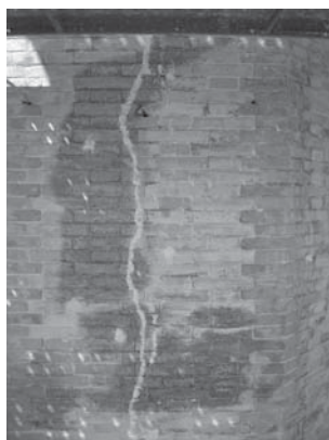
Vista lateral xemeneia. Vista una vegada neta, exempta de pols, rejuntades les clivelles i punts de cosit.
