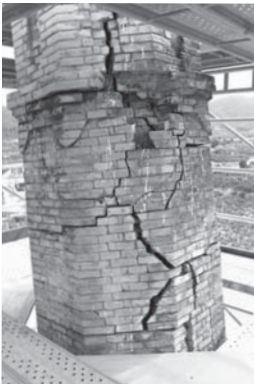
Fust de la columna. Vista nord-est
