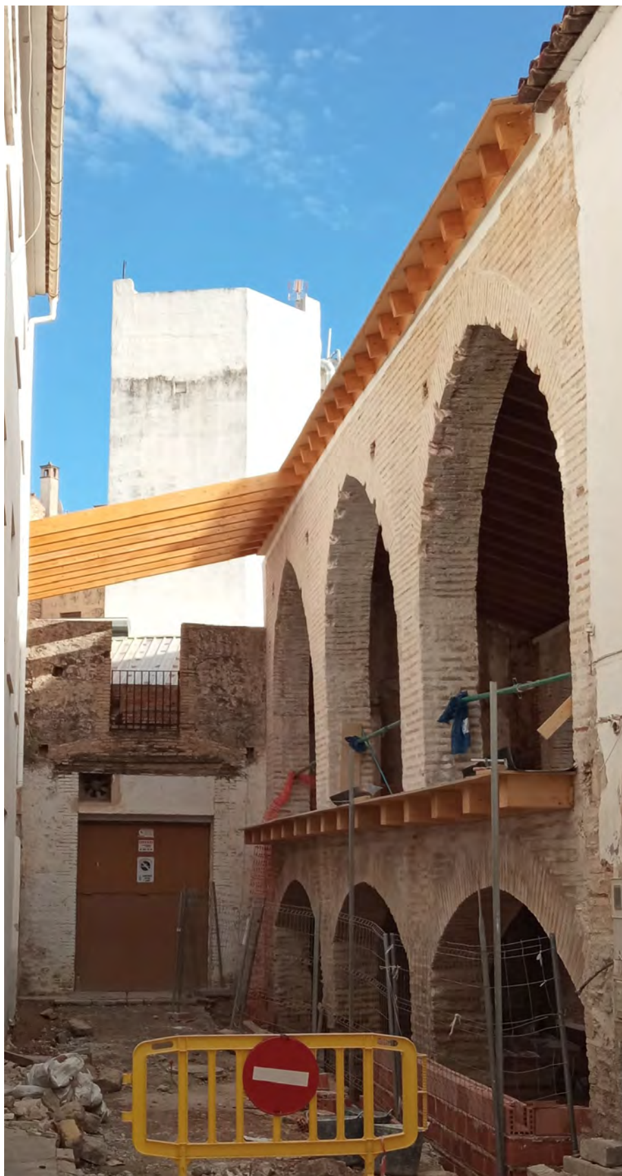
Figura 18. Cases de l'Enginy durant les obres de restauració (agost de 2020).
