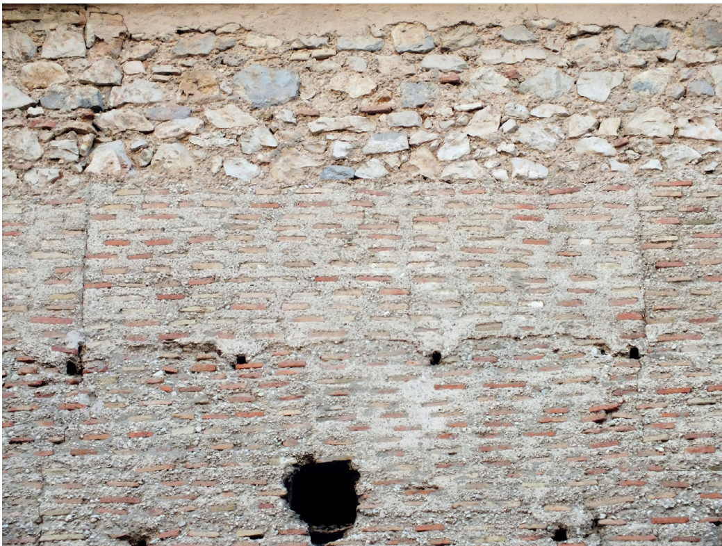
Figura 6. Detall de la tàpia de rajola de l'edifici de 1606.
