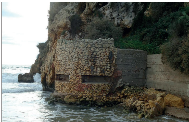
Figura 4. Vista d'una casamata a Tarragona (1937. Consultat des de GRIEGC-Grup de Recerca i Investigació d'Espais de la Guerra Civil [en línia], < http://www.griegc.com/ >).
