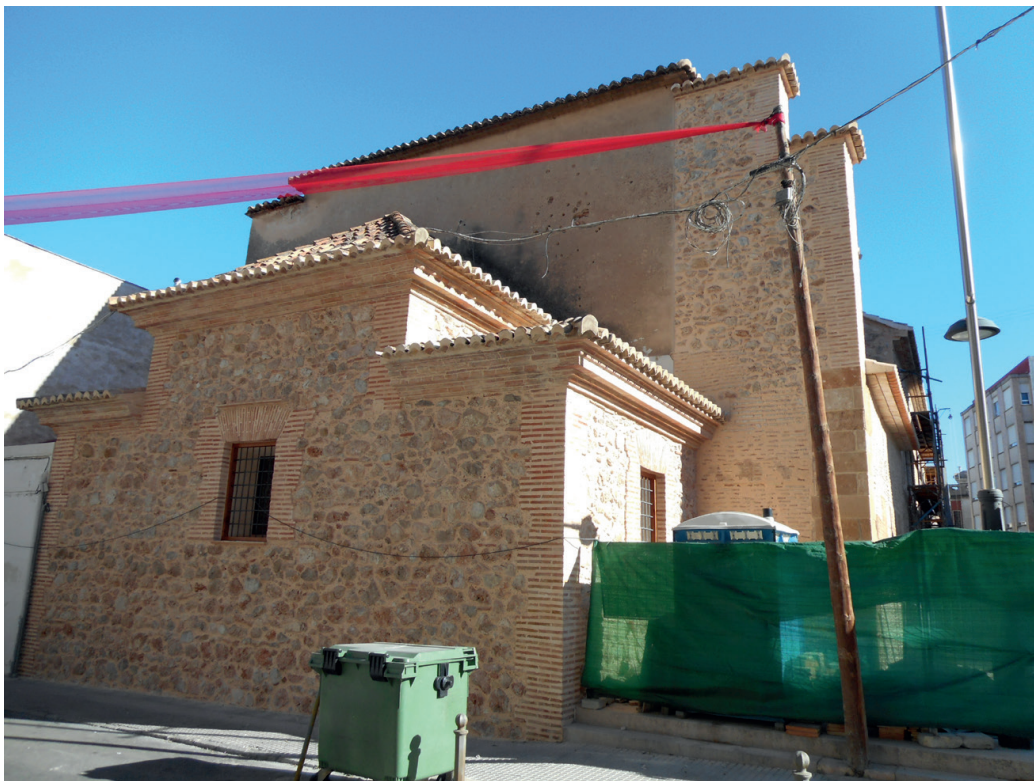
Figura 4. Façana de ponent amb la sagristia afegida al cos de l'església.
