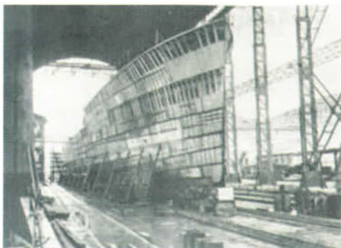
Situació de les obres del casc d'un dels destructors en construcció de la classe Churruca. Març de 1932. Arsenal i Drassanes de Cartagena
