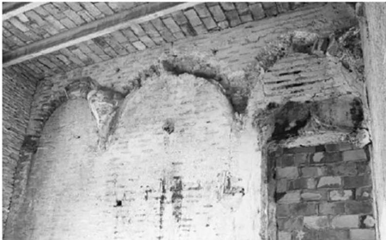
Figura 3. Improntas y restos de los arranques de la bóveda.
