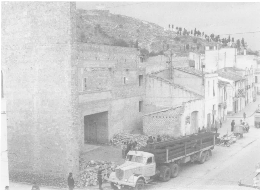
Transport amb camions de les vigues i acopis de material.
