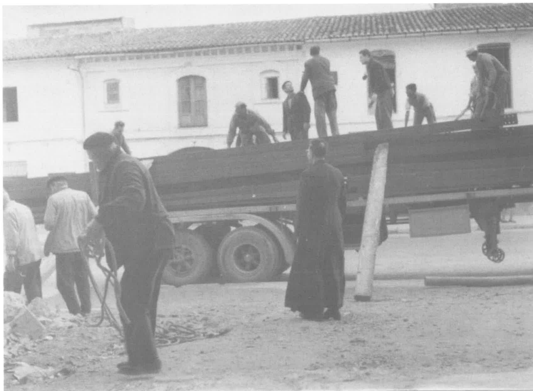
Arribada del es vigues de la nau central.
