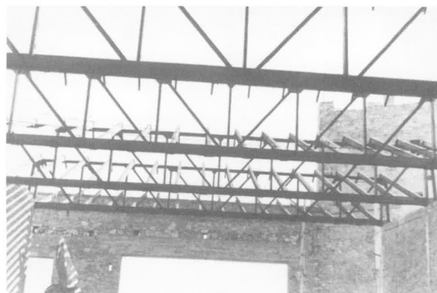
Imatge de la col·locació de les bigues triangulars tipus Pratt i dels perfils laminats utilitzats per a cobrir la nau central del temple parroquial de Sant Francesc d'Assís.
