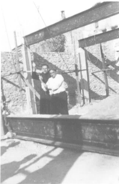
Imatges del procés de col·locació de vigues de ferro del sostre del temple provisional. (Actual centre parroquial)
