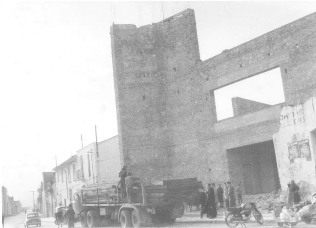
Imatge de la construcció del temple parroquial, on podem observar les bigues triangulars tipus Pratt transportades pels camions.
