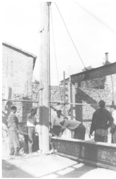
Imatges del procés de col·locació de vigues de ferro del sostre del temple provisional. (Actual centre parroquial)
