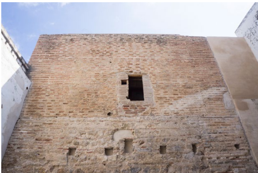
Imatge de detall dels murs de la torre sud-oest de la fortificació medieval. Es veuen, el mur de tàpia valenciana en la part superior i el mur de tàpia mixta de pedra i rajola amb formigó de calç en la part inferior. (El fabricante de esferas, 2018).
