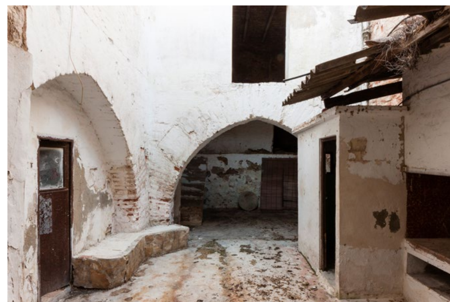
Imatge dels arcs apuntats de rajola existents en l'interior d'una de les vivendes del carrer Palau (El fabricante de esferas 2018).
