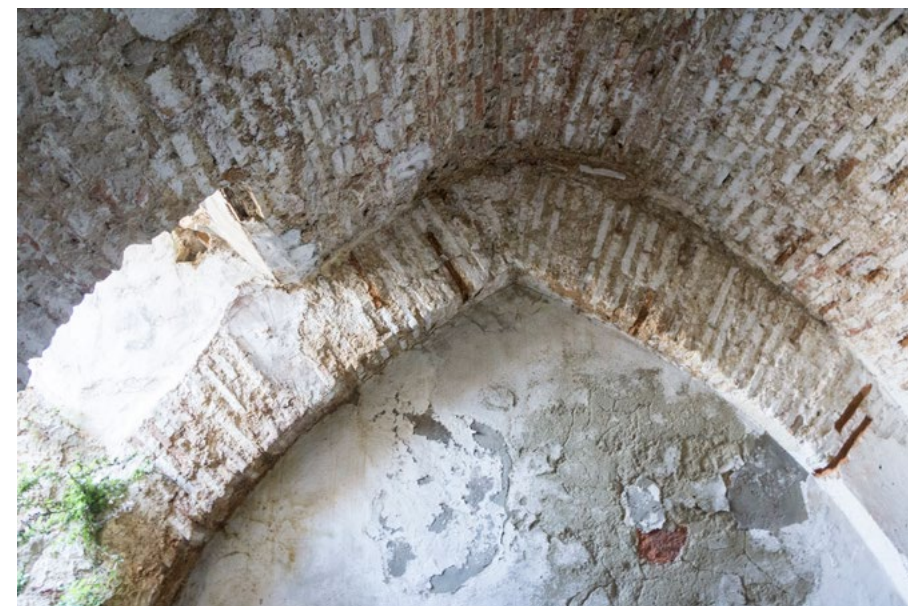
Imatge de la volta de canó apuntada de rajola a rosca existent en l'interior d'una de les vivendes del carrer Palau (El fabricante de esferas, 2018).
