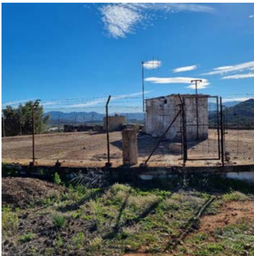
Dipòsit d'aigua propietat d'Aguas Bolinches. Arxiu propi.
