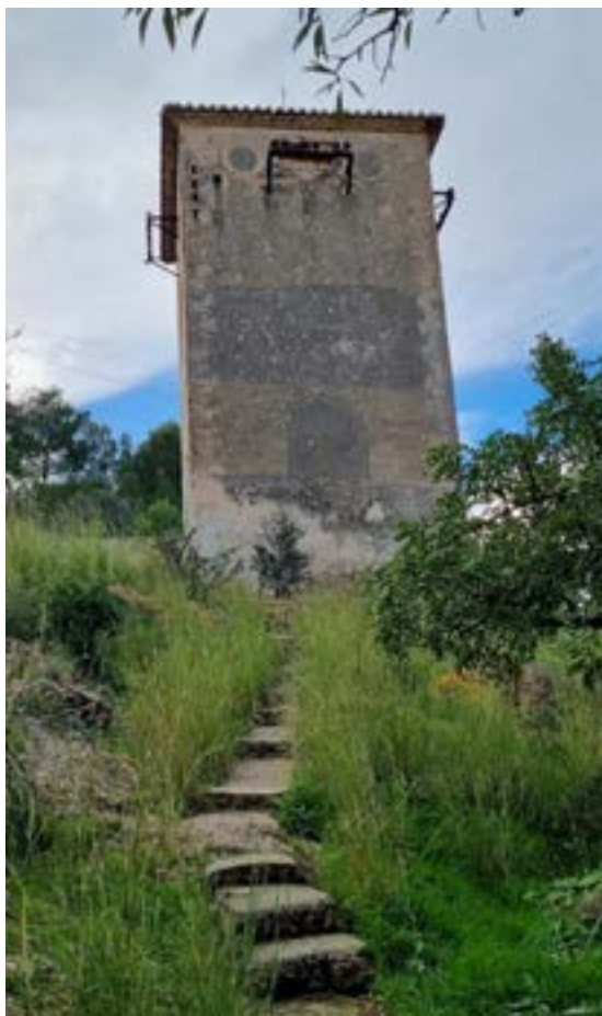
Torre elèctrica en desús proposada per ser convertida en una torre d'escalada. Font: arxiu propi.
